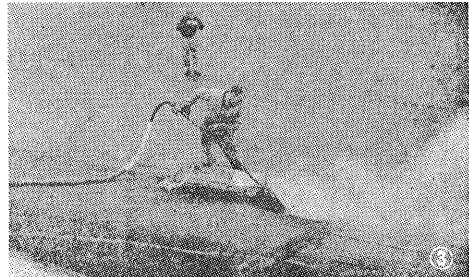
**湿潤** (Surface damp) とでも言えよう。タック・コートには、SS-1 アスファルト・エマルジョン (SSはSlow setting 即ち緩硬性の意) を水で1:1に稀釀して用いた。乳剤の撒布には、普通のウィード撒布機 (Weed sprayer) を用い、0.04 gal/yd<sup>2</sup> (0.142 liter/m<sup>2</sup>) の割合で撒布した。第2図に、清掃してタック・コートを施した部分と未改修部分との比較を示しておいた。天候が不良であったため、タック・コート完成後、アスファルト薄層の施工まで約7日間の遅れを見た。
