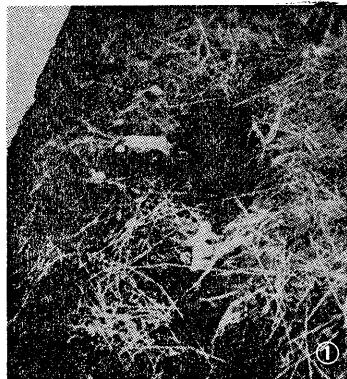
亀裂の原因。——乾湿の差により、このように大きな容積変化を示す土壤(大きさを示すカメラに注目されたい)は、水路の側壁防水層たるコンクリートに重大な悪影響を及ぼす。
