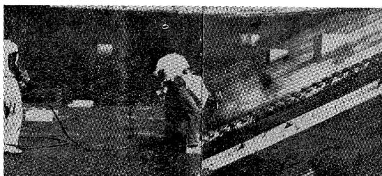
写真② 5百万ガロンのラハブラ貯水池 (La Habra reservoir) に施したアスファルト薄層の厚さは  $3/8\text{in}(9.5\text{mm})$  である。基層には、アスファルト質のプライムコートを施し、薄層に対する保護被覆としては、ポルトランド・セメント・コンクリートを用いている。
