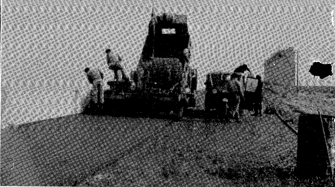
アスファルトフィニッシャーによる堤防天端舗装
