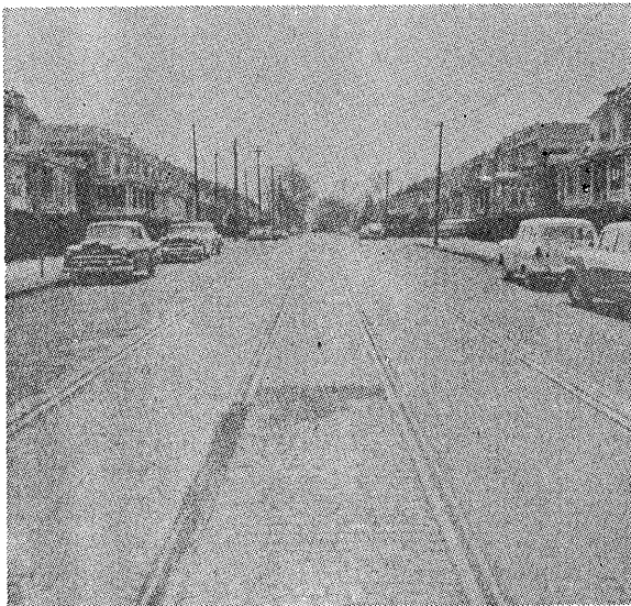
施工前 Sirtieth Street の廃止した電車線路と部分的な被覆
