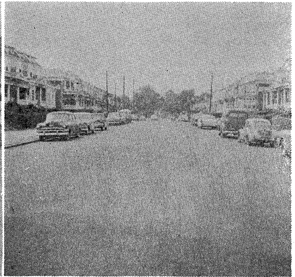
施工後 今日の Sirtieth Street はアスファルトコンクリートで全巾員が被覆された。
