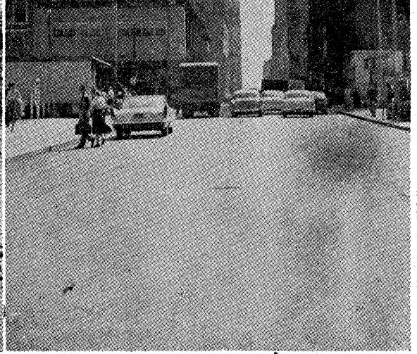
施工後 線路と石塊舗装はアスファルトの中に埋められた。
