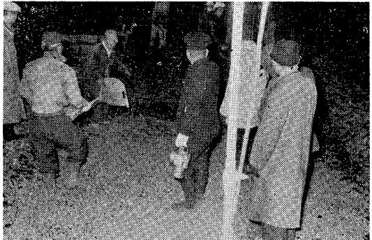
写真-24 インパクトローラー、ビグロランマーによる転圧
