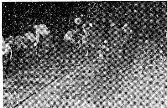
写真-10 アスファルト表面処理碎石のトロより取卸し
