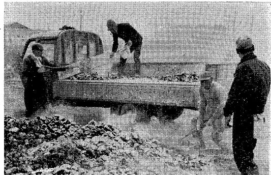
写真-9 旧道床砂利を撤去し、仮受台のそう入
