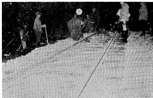
写真-20 軌きょうを吊上機により移動
