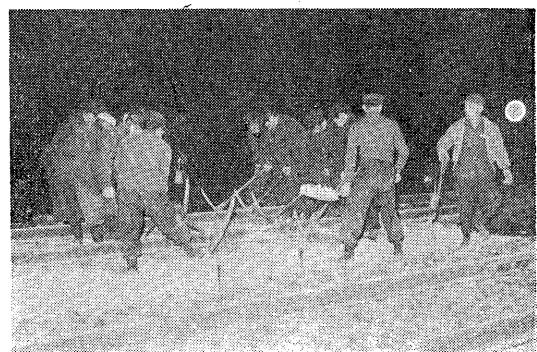
写真-12 タイタンバーによる総搾固め
