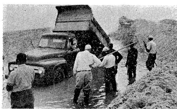
⑯ 海水端 (Ocean end) に加熱合材舗設。舗設中、深さ約3呎の水が存在していた。
