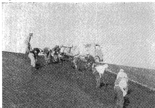
写真—12 同上部 人力に依る敷均作業
