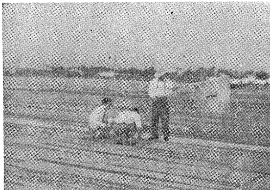
写真-5 滑走路で危険信号旗を持って サーモペイント塗装中
