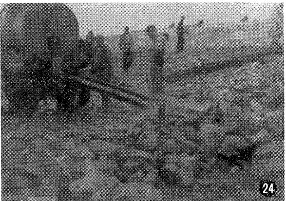
第24図 栗石にマスチックを填充しているところ、碎石の大きさは直径20乃至40cm、総厚90cm、マスチックは約700kg/m<sup>2</sup>使用されている
