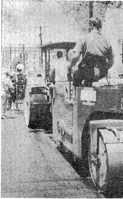
第2図(左上)アトランタの工事では、ローラーが、ペーパー(Paver)の直後に接近して作業することができた。
