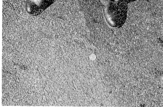
第31図サーフェースドレッシングの路面
