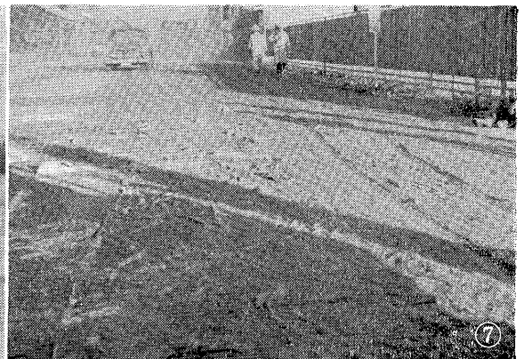
参考(3) セメントマカダミックス施工直後の交通開発前の状況 (左上) 同じく開発した状況 (右上)
