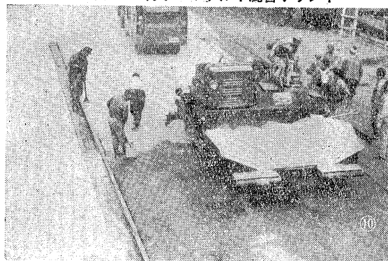
写真—10 カラーファルト舗装の舗設作業
