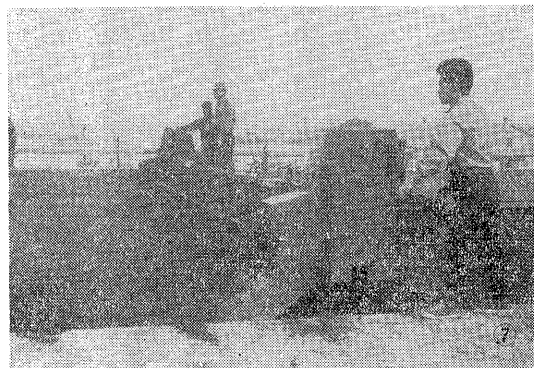
写真-7 グースアスファルト用スパイクローラー
