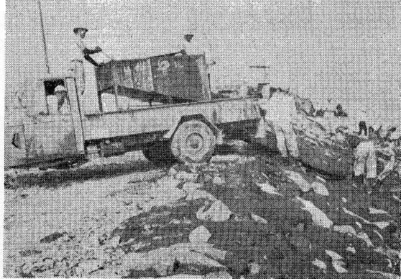
写真一8 水面上の捨石マウンドからサンドマスチック注入
