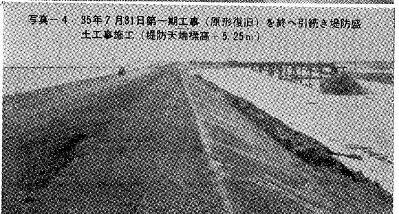
写真-4 85年7月31日第一期工事(原形復旧)を終へ引続き堤防盛土工事施工(堤防天端標高+5.25m)
