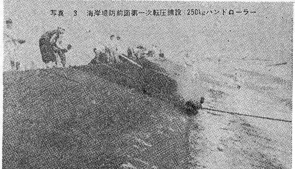
写真-3 海岸堤防前面第一次転圧舗設 250tハンドローラー
