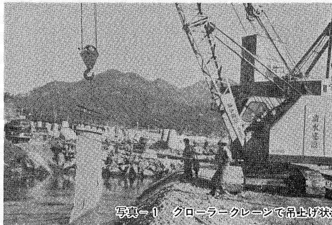
写真-1 クローラークレーンで吊上げ状況
