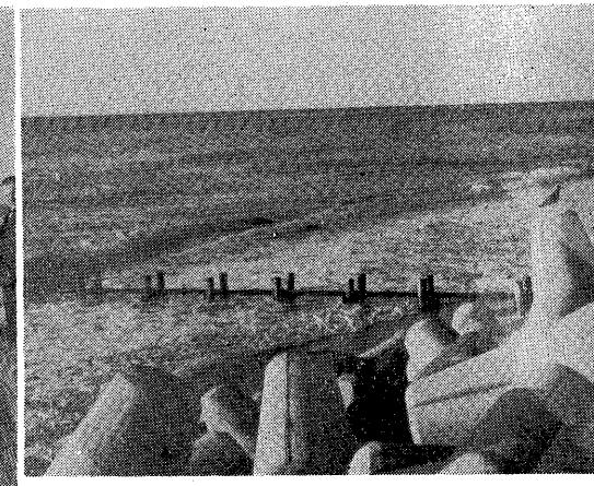
写真-3 煉瓦造垂直壁とテトラボッドおよび豎堤
