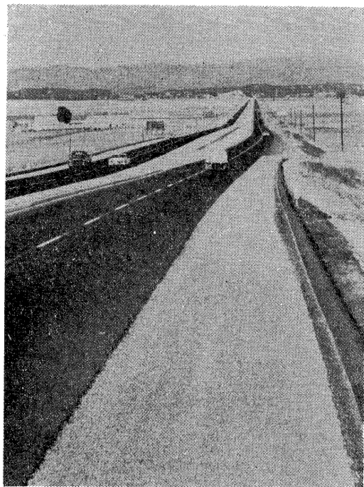
IX-3図 アスファルト・カーブ(縁石)
