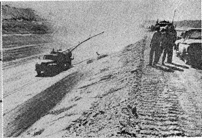
ディストリビューターで水路の側法に加熱アスファルトを吹付けている。特殊吹付け用棒状ブームに注目。
