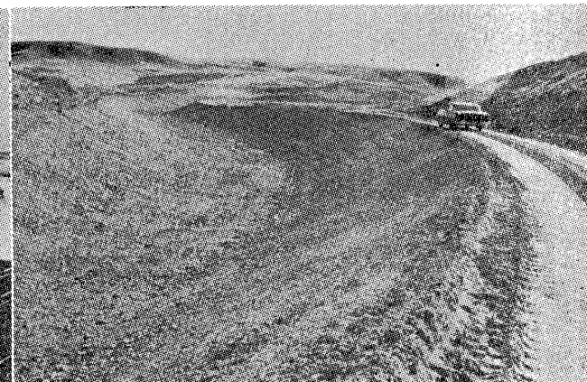
完成した水路、滲透防止が完了し、数千エーカーの給水地域に灌がい水を流下する直前。
