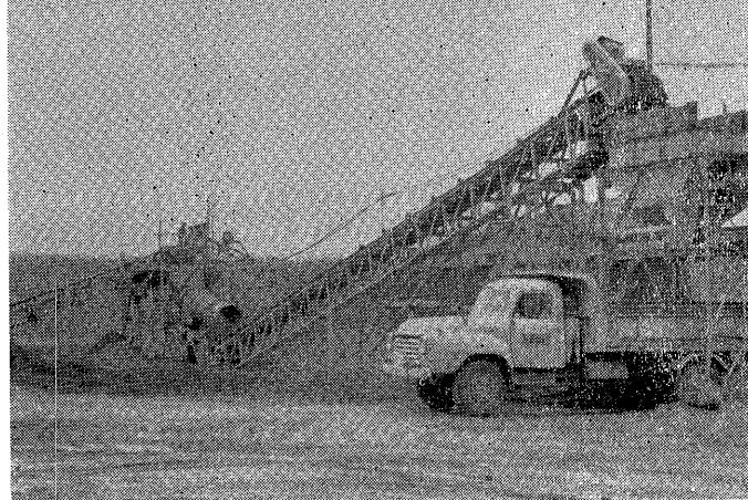
路盤材料生産中のドラムミキサー式
