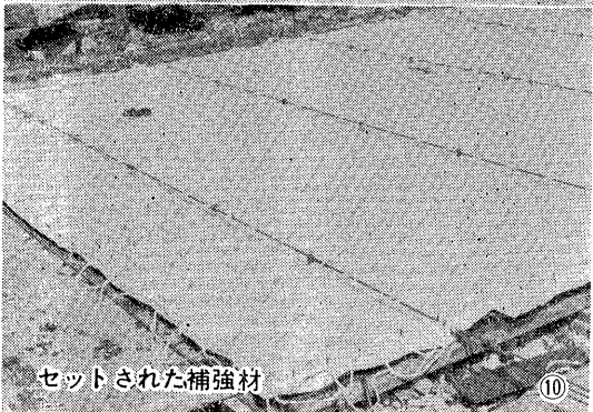
補強材の敷込み
