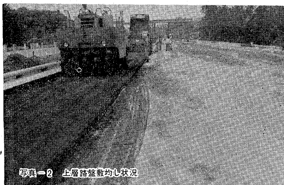
上層路盤 (アスファルト安定処理) 安定度 (lb) 1000 以上 フロー値(1/100in) 4～16 空隙率 (%) 2～15
