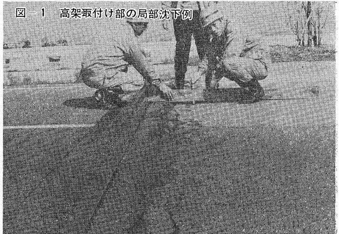
図-1 高架取付け部の局部沈下例
