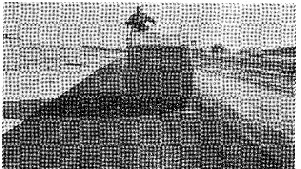
写真一 4 基層の転圧終了
