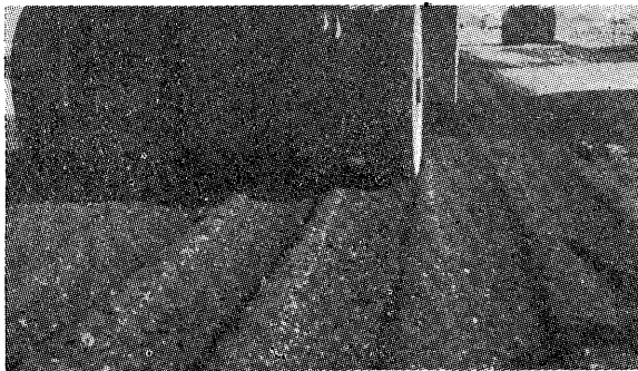
写真一 3 25トンのタイヤローラーによる基層の転圧
