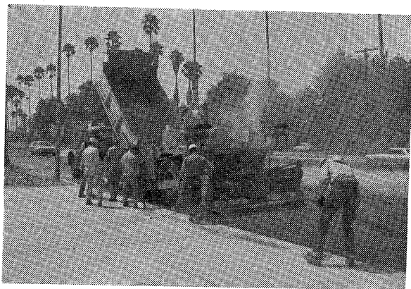
写真— 7 ロス市直営のオーバーレイの舗設中
