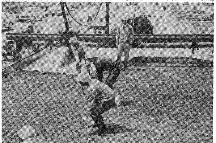
写真一4 アスファルト褥層上へのコンクリート打設作業
