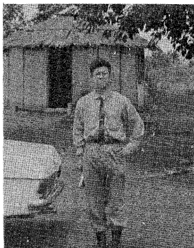
写真左 未舗装の道路の維持補修のために8 kmおきにキャンプが設けられ、約6名1組で直営で実施している。
