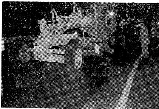
写真-9 切削されて中央に集った混合物をローダにより積み込み作業
