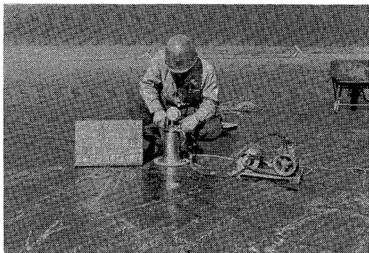
写真-6 ジョイント部の補修作業 バイブレーションタンパで締固める。後方がジョイントヒーター（間接加熱式）でジョイント部を加熱昇温する。
