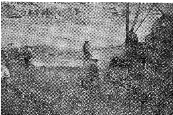
写真-4 密粒層舗設中で手前が敷均し速度測定中。中央の白煙はローラ輪体に散水した余剰水が斜面を流れ水蒸気化している。その下がBW75がウィンチデッキより操作されている。
