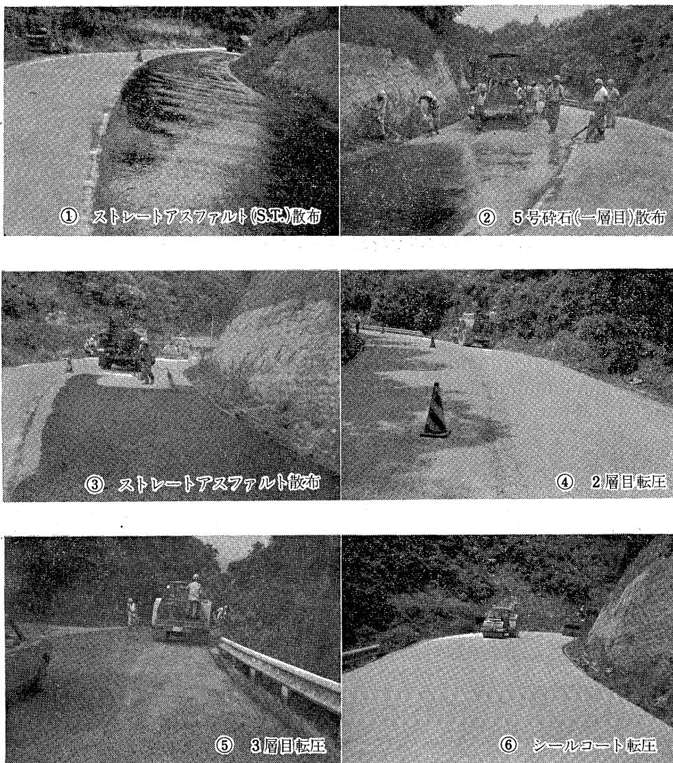
工種は路盤工3種、表層工種6種あり、それらの組合せにより、9種の舗装断面に構成されたもので、工区割と舗装構成以下のとおり。
