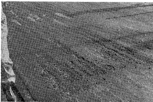
写真-2 ゴム入りアスファルト混合物がタイヤにより持ち去られた跡、白いのは付着防止用乳剤と蒸気
