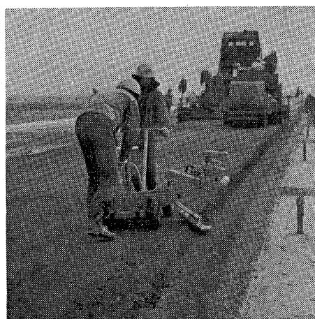
たので、これと比較してタイヤの接地圧がほとんど変わらない前述のタイヤローラで充分な締固め効果が得られている。加熱混合物を締固める場合、タイヤによるニーディング作用により不透水性が増すといわれており、表面のキメを重視するとタイヤローラによる転圧が必要となる。そこで小規模な工事に3トンタイヤローラが使用され、締固め効果よりむしろ表面のキメをよくする効果が認められている。
