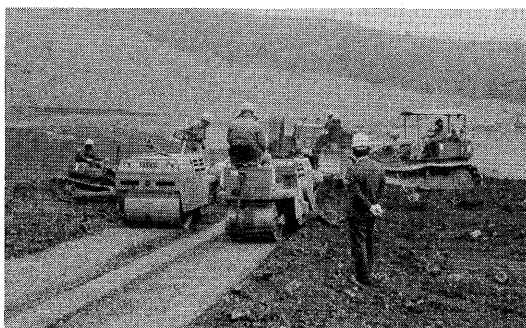
写真-2 アスファルトコアの施工 (拓殖大・八王子) 施工：鹿島建設一大成建設JV
