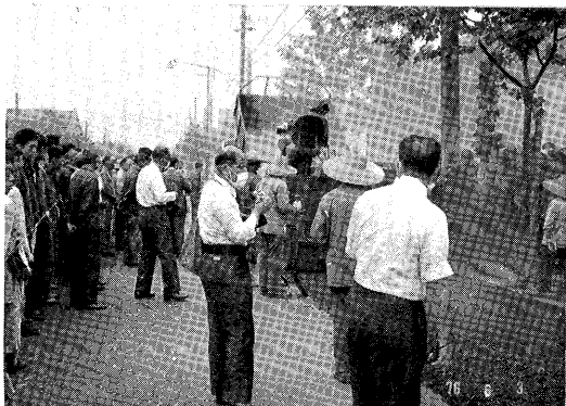
舗設現場（上海江寧路）
