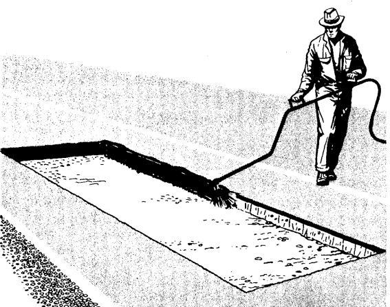
図-2 垂直切取面にタックコートを施す
