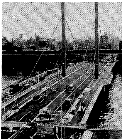
写真－2 新大橋（鋼床版）PM－1防水と改質アスファルトコンクリート舗装を施工
