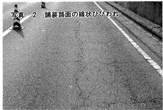
写真-2 補装路面の線状ひびわれ
