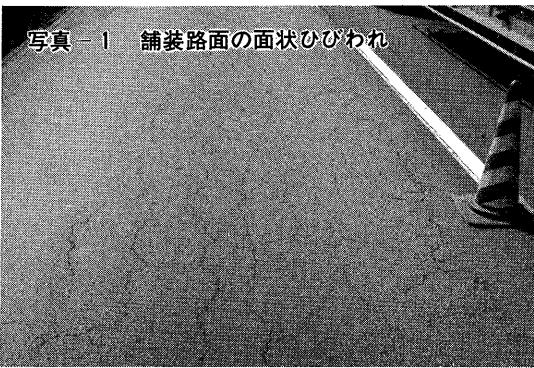
写真-1 補装路面の面状ひびわれ
