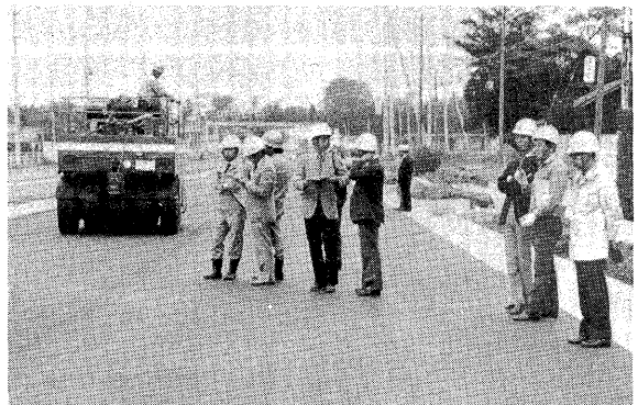
試験施工に立ち合う分科会幹事(56. 11. 5. 御殿場)
