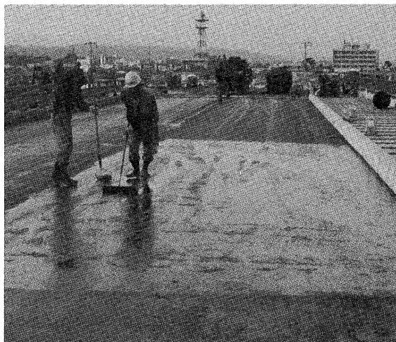
写真-6 硬化性アスコン施工区間のタックコート
