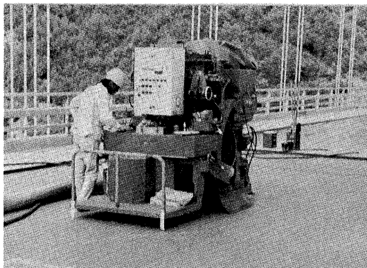
写真-1 バキュームブラスト機による研掃
