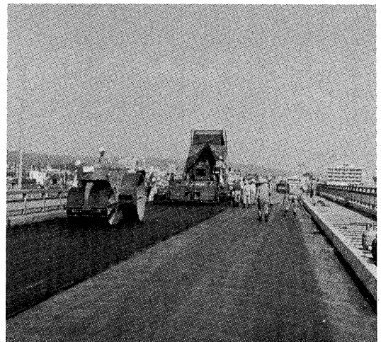
写真-8 表層の舗設
