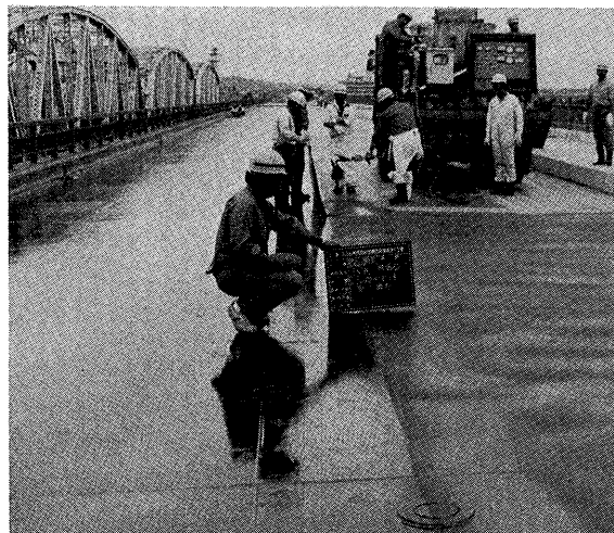
写真-5 硬化性アスコン施工区間の接着層散布
