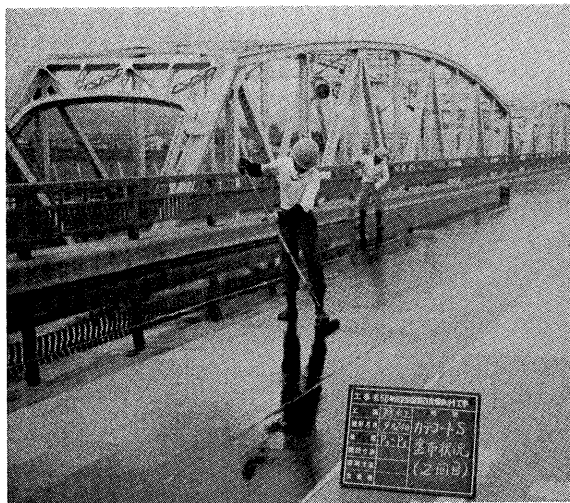
写真-4 改質アスコン施工区間の接着層塗布
