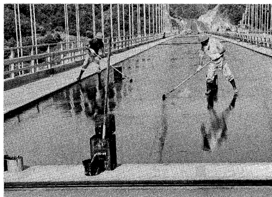
写真-2 接着層の塗布
