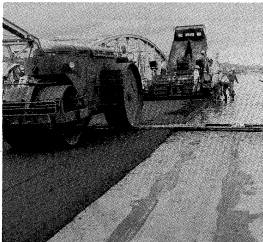
写真-7 基層の舗設
