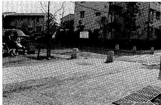
写真-18 小山田桜台団地の歩行者専用道路（仮粧平板舗装）と車道が平面交叉する部分のカラーアスファルト舗装
