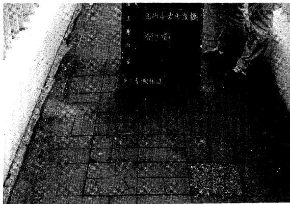
写真-1 アスファルトブロック舗装の破損
