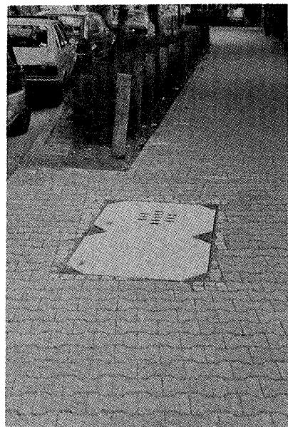
写真-3 西ドイツの組合せブロック舗装
