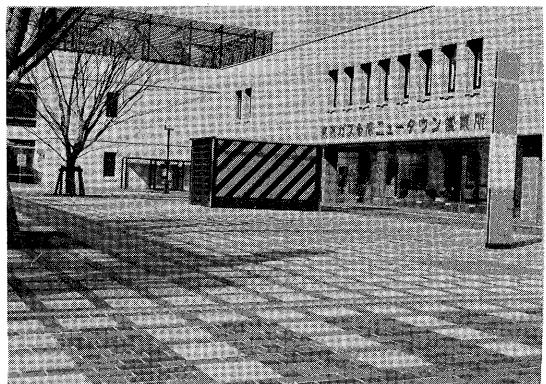
写真-2 多摩センター業務施設広場の炻器質タイル・自然石舗装
