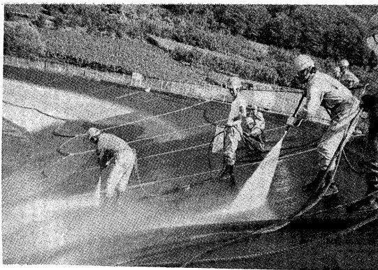
写真-5 ウォータージェット洗浄工
