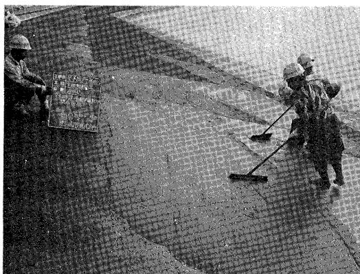
写真-7 常温材目潰し、塗布状況
