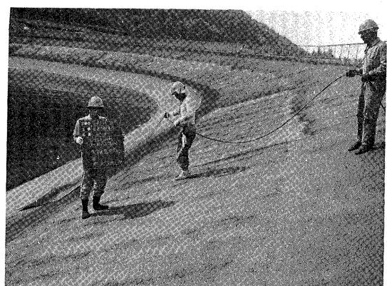
写真-8 表面保護層、吹付け状況
