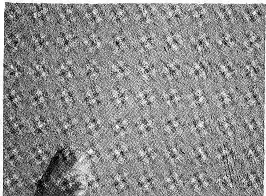
写真-9 表面保護層、仕上り状況 (9ヵ月経過後)
