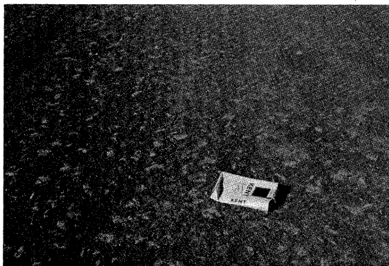
写真-6 上層路盤完了後の路面
