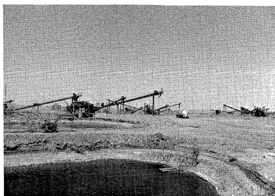
写真-4 骨材プラント
