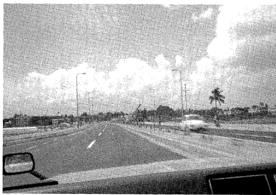
写真-1 スレンダー橋梁工事の全景
