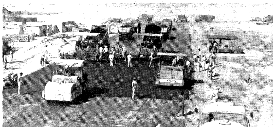
写真-7 バインダー試験施工
