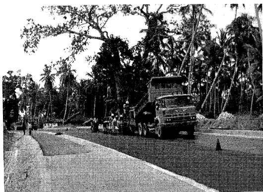
写真-2 ザンジバル7 km道路工事舗設状況
