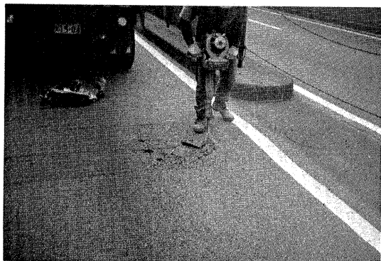
① 不良箇所をブレーカにより切り取る
