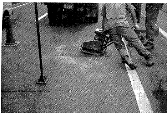
④ 舗設、転圧を行い、表面に石粉や砂を散布して交通開放する
