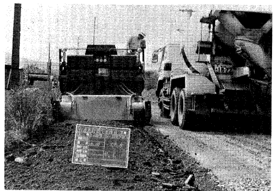
写真-10 一次混合状況
