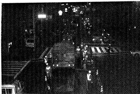
写真-3 切削作業中の状況
