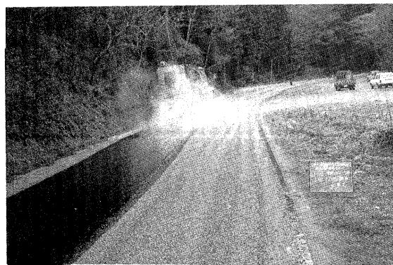
写真-2 1層目乳剤撒布状況
