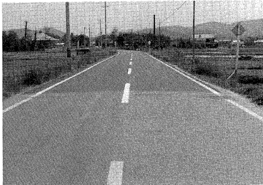
写真－３ 特殊バインダー（カットバックアスファルト）による撒布式表面処理工
