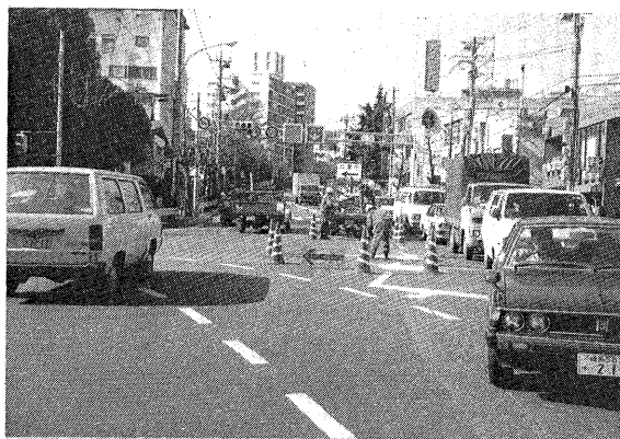
写真-1 作業風景
