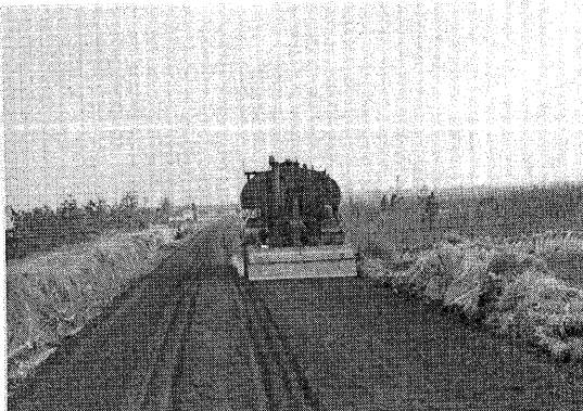
写真－２ 昭和40年代前半の直営機動隊による路盤改良
