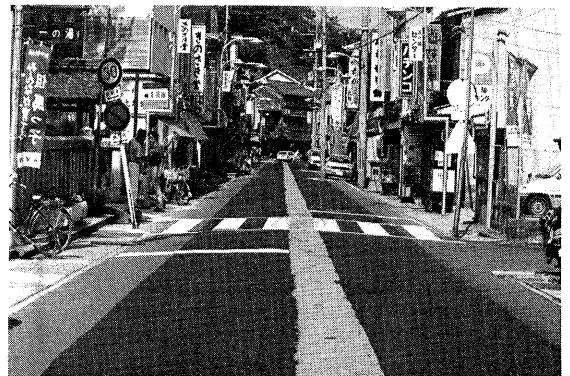
再補修後 (60年8月)
