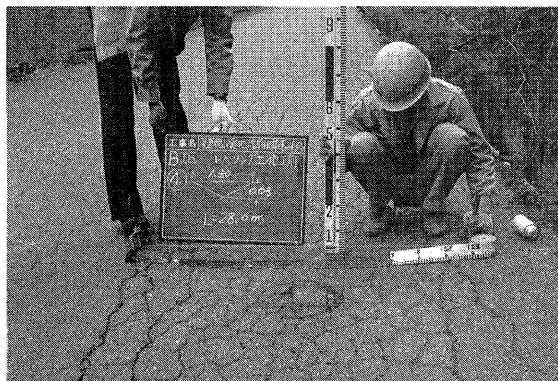
写真-1 レベリング施工前
