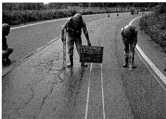
写真-1 レールびき維持補修施工前 (網状クラックが発生している場合は部分打替を行う)
