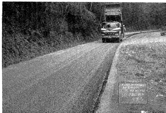
写真-3 1層目6号碎石撒布状況
