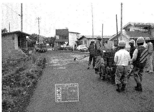
写真-18 乳剤撒布状況
