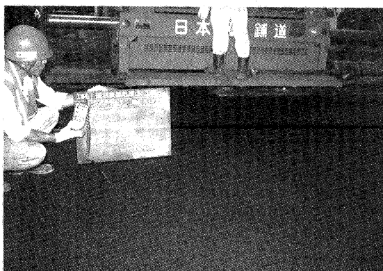
写真-7 リペーパーによる3cm熱解砕+2cm分の新規混合物を混合敷均し状況
