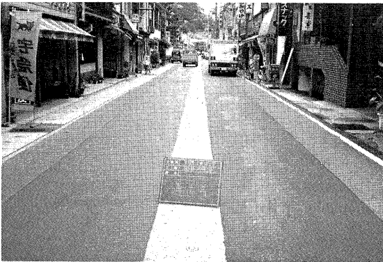
写真-6 施工後の摩耗状況 (60年4月)
