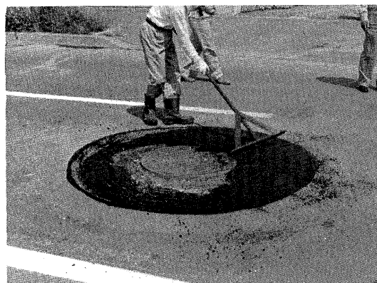
再生混合物敷均し
