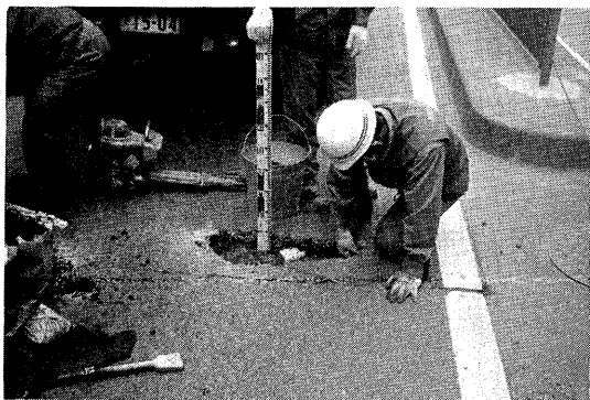
② 遊離したアスコンを取り除き整形する
