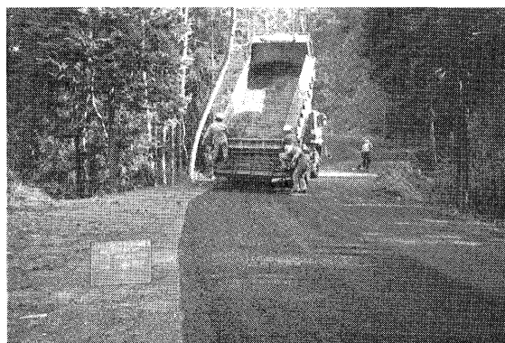
写真-6 2層目7号碎石撒布状況
