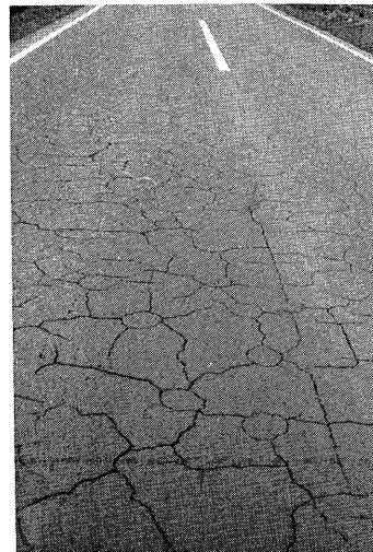
写真一7 特殊アスファルト舗装の収縮ひびわれ
