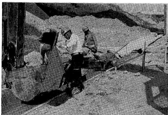
写真-5 仮水路 簡易フィニッシャによる施工
