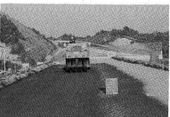
写真-8 下層路盤タイヤローラによる散水、転圧
