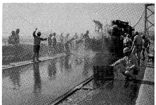
写真-3 下層グースアスファルト試験施工
