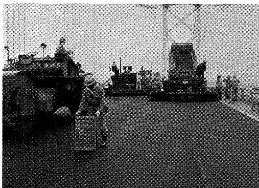
写真-4 上層改質アスファルトコンクリート
