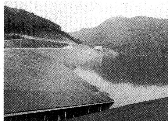
写真-1 アスファルト混合物による表面遮水型ダム
