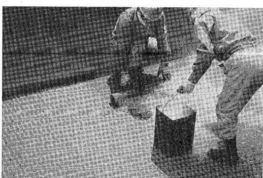
写真-4 アスファルト防水工事に於ける煙の発生状況(2)
