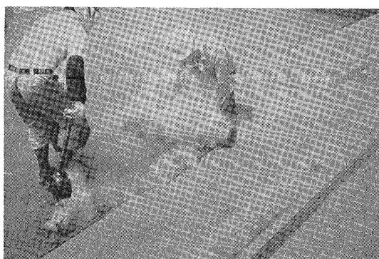
写真-3 アスファルト防水工事に於ける煙の発生状況(1)
