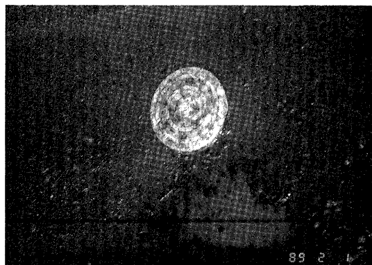
写真-2 検知器周辺の表層部の破損
