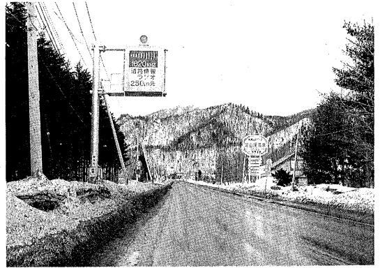
写真—3 路側通信システム
