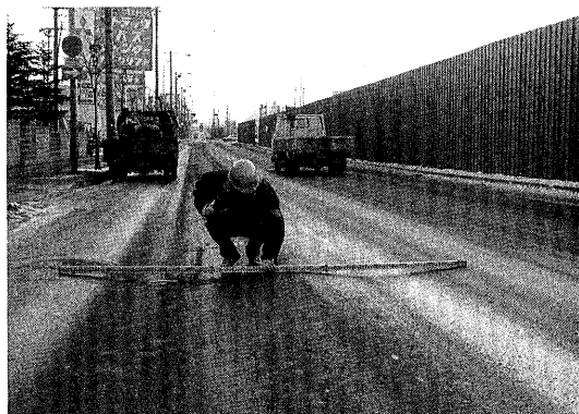
写真—1 スパイクタイヤによるわだち掘れ
