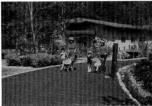
**写真-5** 天然コルク粒を用いた弹性カラーアスファルト舗装。コルクの持つ弾性機能により、ソフトな歩行感を与え滑りにくく、歩きやすい舗装となっている。
