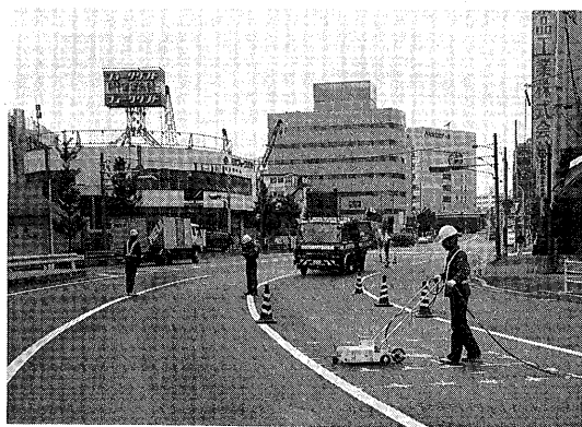
写真－2 メッシュ調査作業状況
