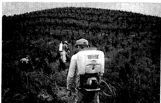
写真-3 噴霧器によるアスファルト乳剤の散布
