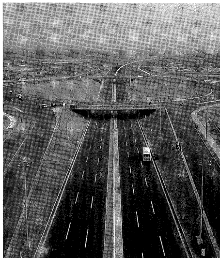
写真－6 北京－石家荘高速公路
