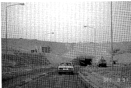
写真-8 スエズ運河の下を潜るトンネル
