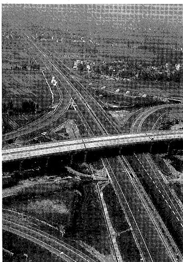
写真－5 広州－佛山高速公路
