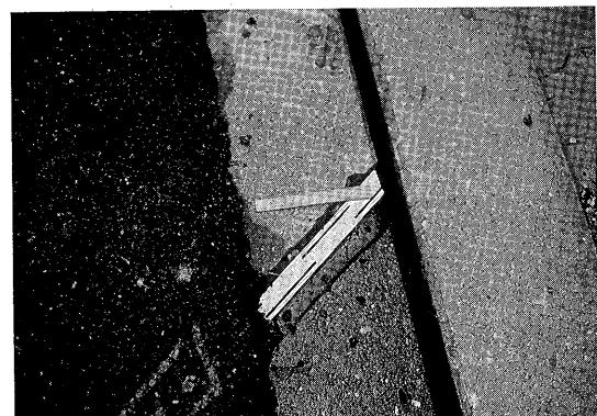
写真-6 排水性表層の下に入れた排水用グリットパイプ、ドイツ
