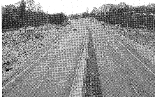
写真-1 高速道路における冬季の路面管理の現状 (スウェーデン)
