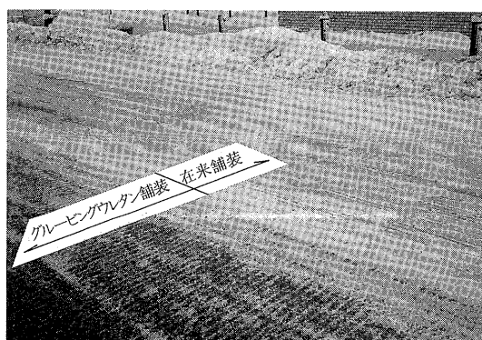
写真－２ 雪水の剝離効果が現れたグルーピングウレタン舗装
