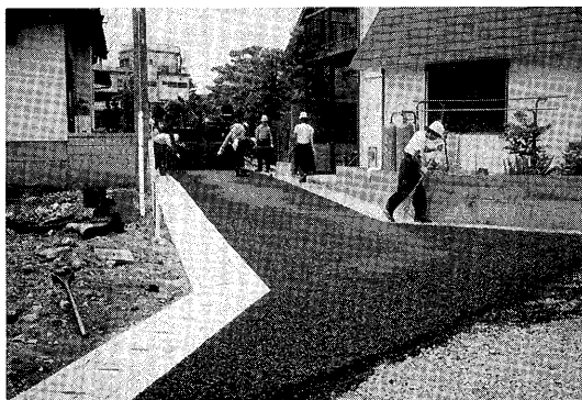
写真－５ 開粒度常温混合物による生活道路の舗装
